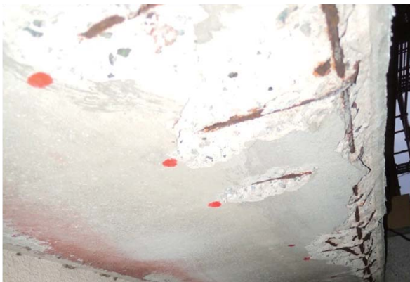
スラブ裏(軒天)の爆裂が顕著に見られた。地面からの湿気を多く受けたことが原因と考えられるため、補修後、吹付タイルで仕上げることで吸水しないよう対処した。
