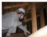
構造体の小屋裏・床下状況確認
