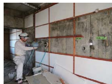
コア抜き調査
