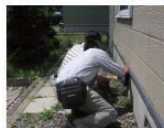
基礎鉄筋の探査状況
